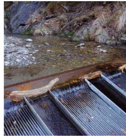
Manipulierte Überläufe an Kleinwasserkraftwerken. Das zusätzlich abgeleitete Wasser fehlt in der Restwasserstrecke und kann im Extremfall zum Trockenfallen des Baches führen.
