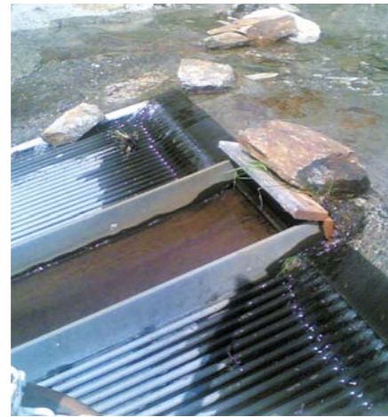
Manipulierte Überläufe an Kleinwasserkraftwerken. Das zusätzlich abgeleitete Wasser fehlt in der Restwasserstrecke und kann im Extremfall zum Trockenfallen des Baches führen.
