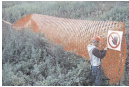
Um Klarheit zu schaffen, lässt die Baufirma eine Betreten-verboten-Tafel anbringen. Daraufhin verlassen die Beobachter die Baustelle, da sie nur legale Aktionen machen.
