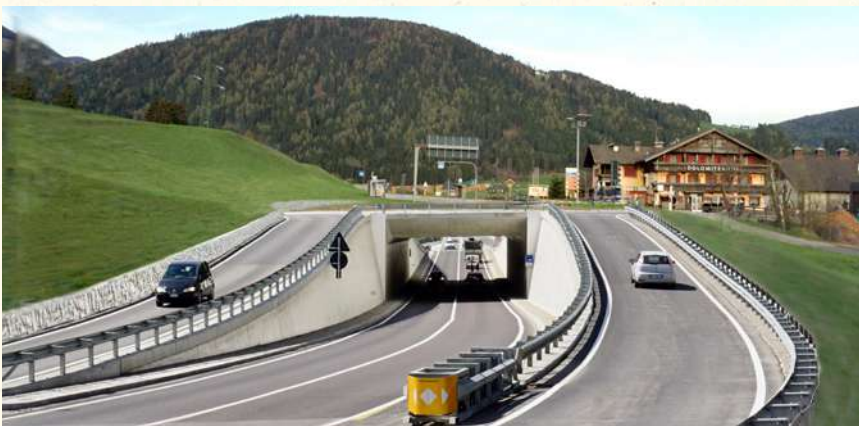
FREIE FAHRT FÜR OLYMPIA: In Innichen soll eine talsperrende, 100 Meter lange Brücke entstehen, in Olang ein Megabauwerk anstatt eines einfachen Kreisverkehrs.
