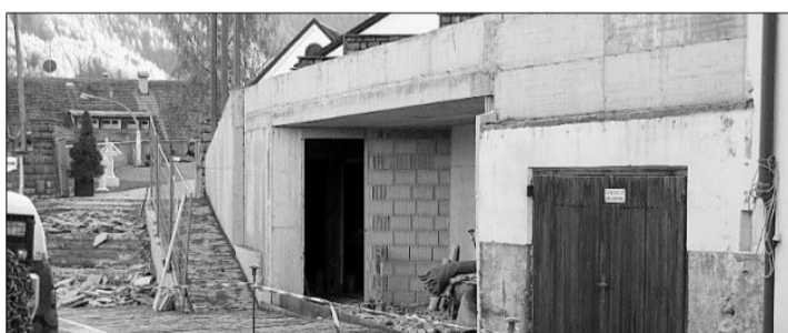
Im Bild die Arbeiten an den neuen öffentlichen WC-Anlagen. no
