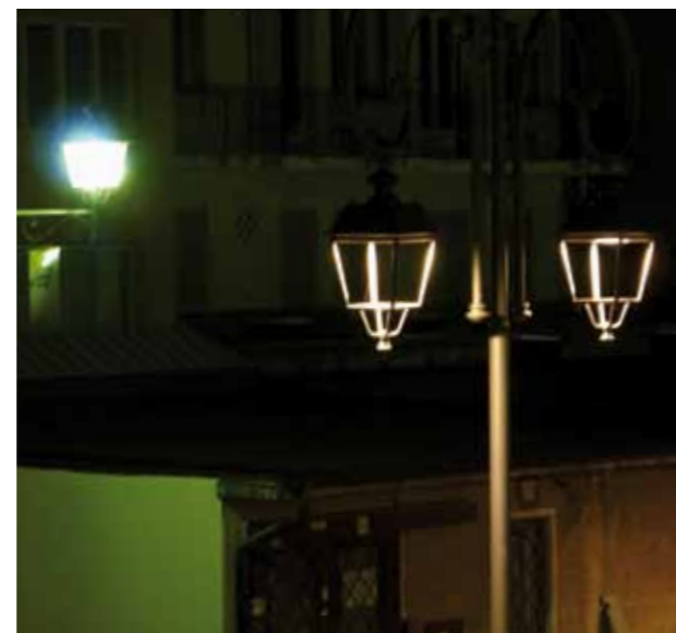
☑ Gelungene Umrüstung von traditionellen Straßenlaternen mit Halogenlampen und Reflektor in der Laternenhaube und ohne Verglasung. Im Gegensatz dazu links die „alte“ Quecksilberdampfampe mit sichtbarem Leuchtkörper, der in alle Richtungen ausstrahlt.
