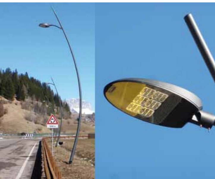
☑ Gekrümmte Masten oder Masten mit auskragendem Arm gewährleisten bei Verwendung der richtigen Leuchtkörpern optimale Lichtverhältnisse.
