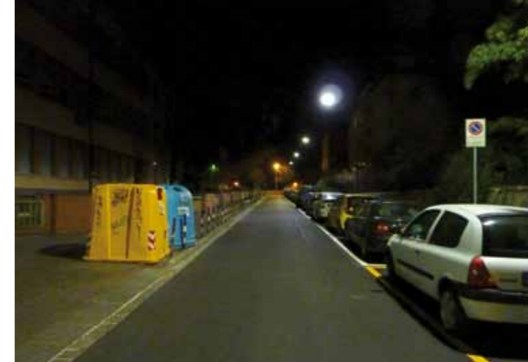
☑ Bozen-Longonstraße: Gelungene Straßenbeleuchtung mit gekrümmten Masten und Full-Cut-Off-Lampen. Kleines Manko sind die zu stark blendenden Lampen, die etwas abgeschirmt werden könnten.
